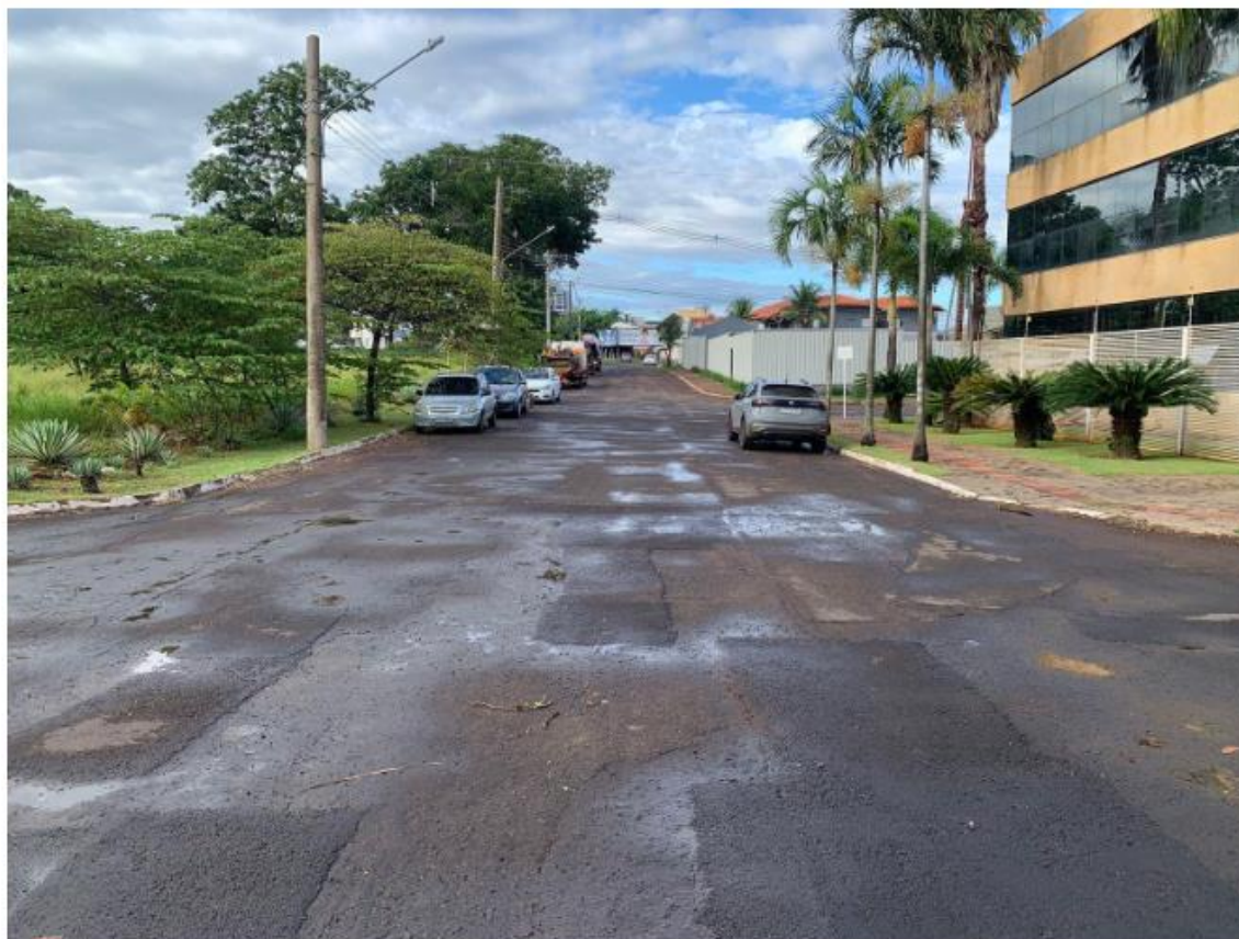
Figura 18: Fotografia do local / Fonte: PMCG
