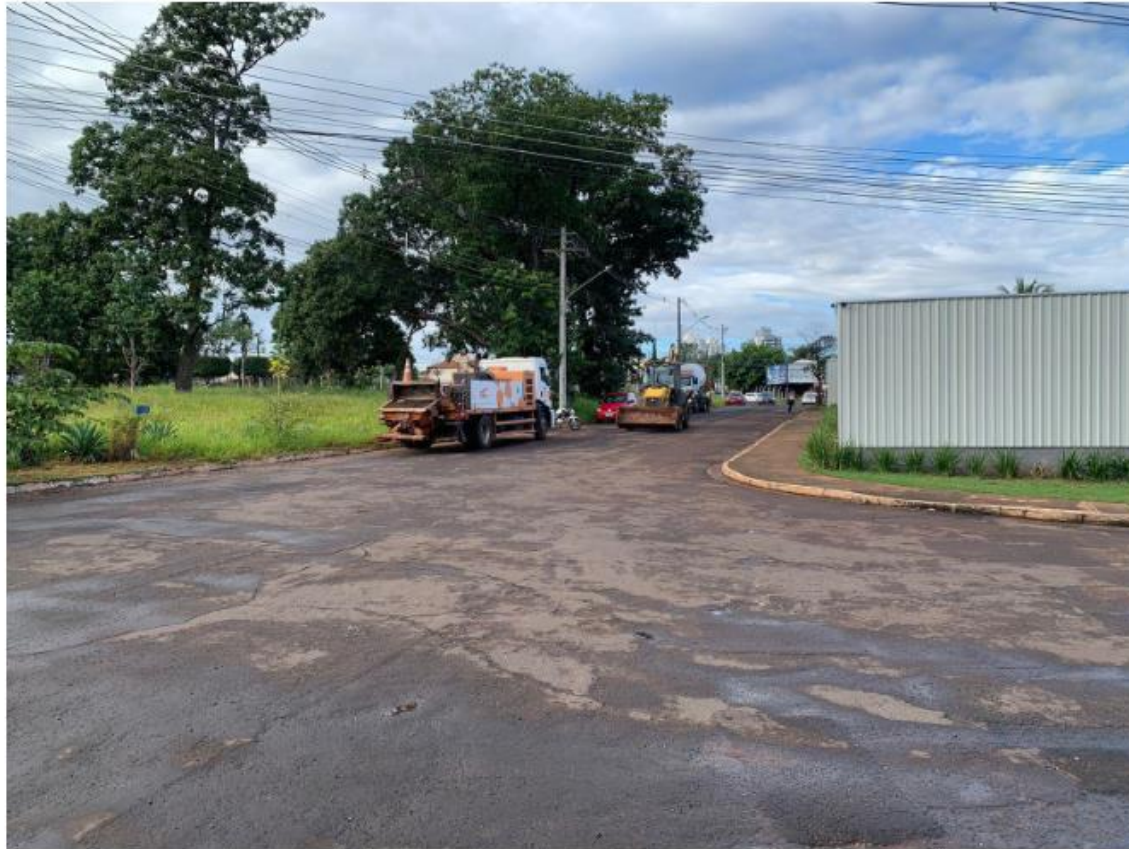
Figura 17: Fotografia do local / Fonte: PMCG
