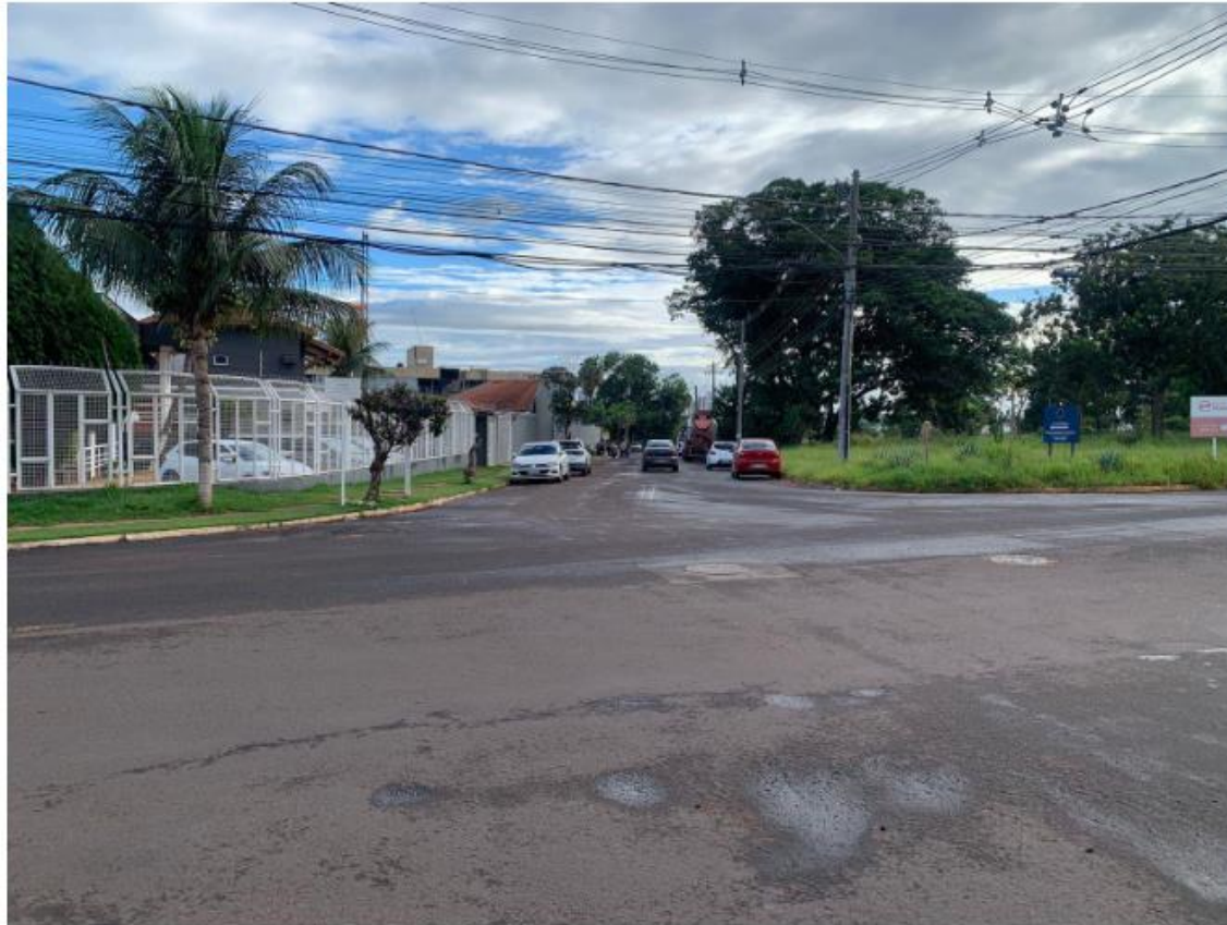
Figura 12: Fotografia do local / Fonte: PMCG
