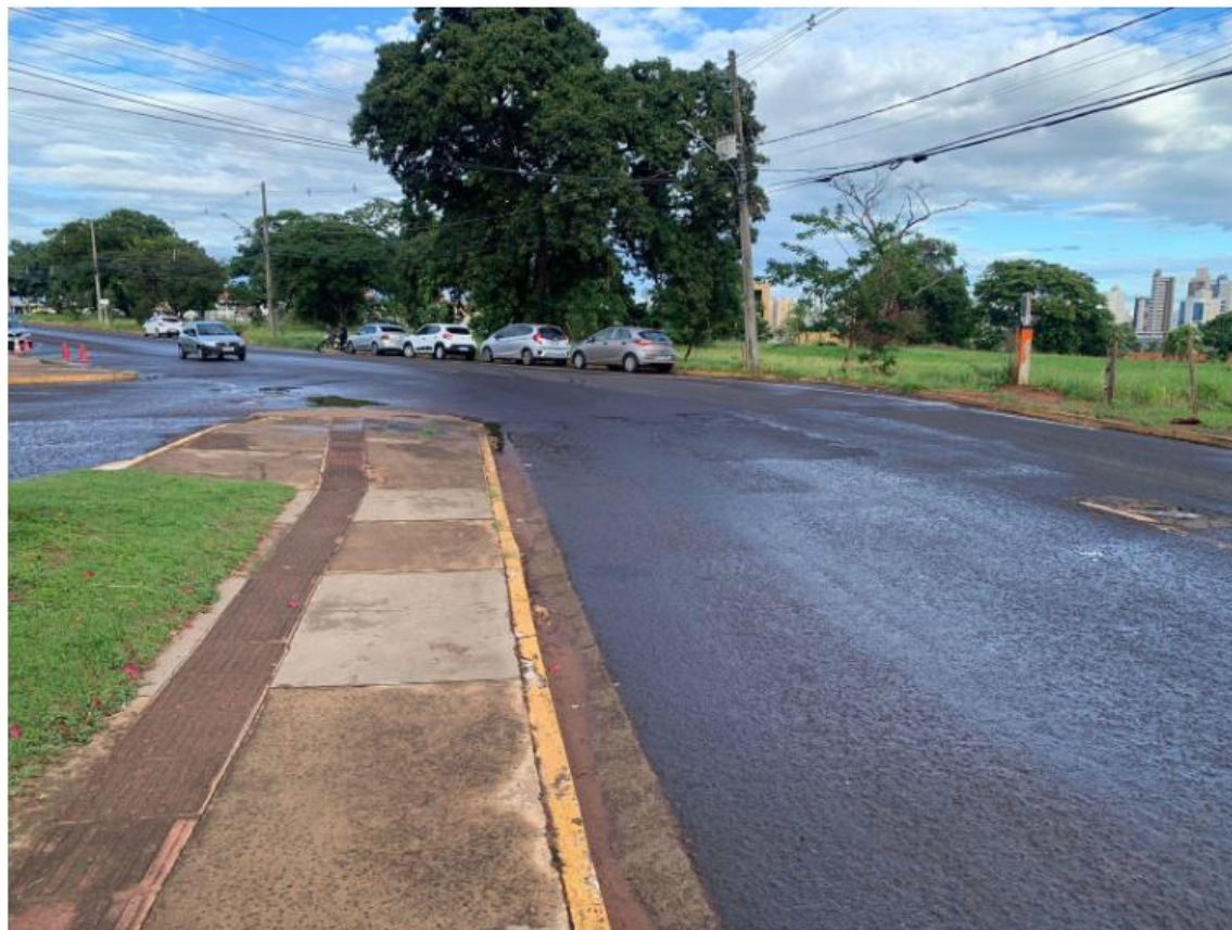
Figura 7: Fotografia do local / Fonte: PMCG
