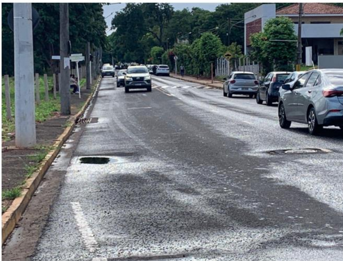
Figura 9: Fotografia do local / Fonte: PMCG
