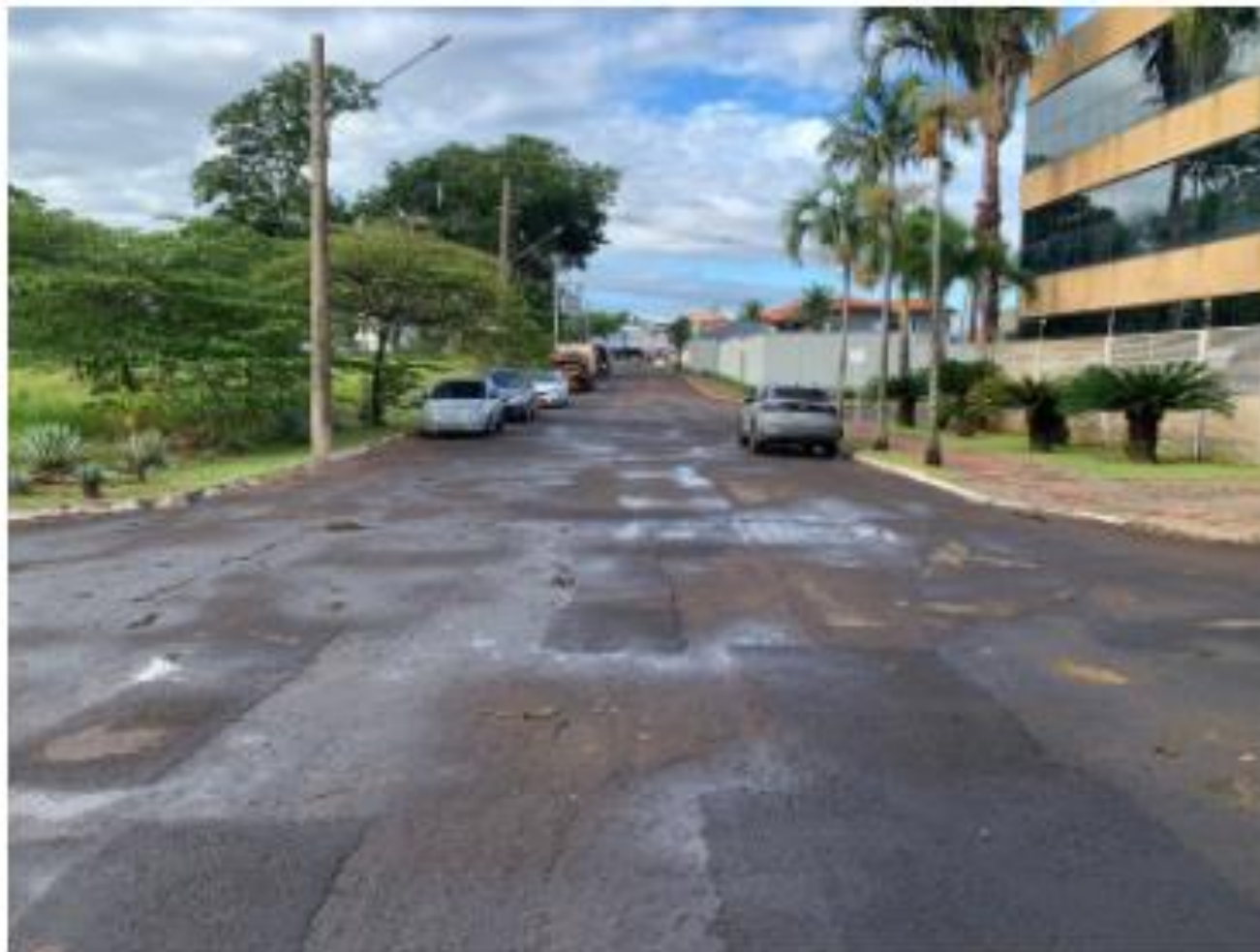
Figura 10: Fotografia do local / Fonte: PMCG
